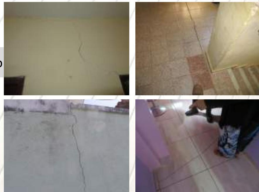
Figura 5: Características das trincas que retratam a área de média instabilidade no terreno.
